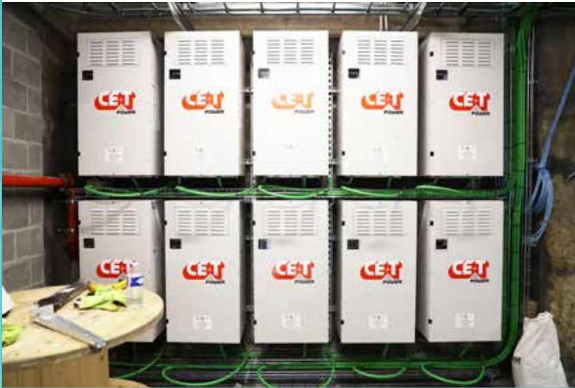
Figuur 1: DE CENTRALE OMVORMERS ZIJN OPGEBOUWD UIT 20 CE+T STABILITI OMVORMERS VAN 25 KW.
