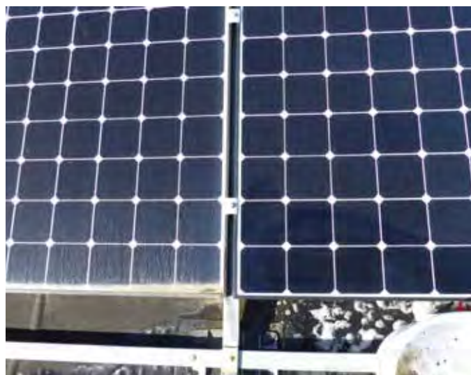
Accumulation de saleté en comparaison avec un module propre.
